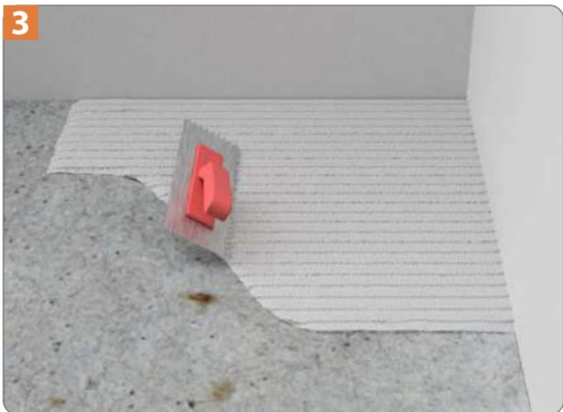
Ultralight treba instalirati pomoću fleksibilnog ljepila na bazi cementa. Ljepilo treba izravnati i češljati pomoću četverougaone gladilice dimenzija 6 mm x 6 mm ( $\frac{1}{4}$ " x  $\frac{1}{4}$ ") kako bi se dobio rebrasti sloj, a sva lagana ulegnuća u podlozi popunjava malter.
